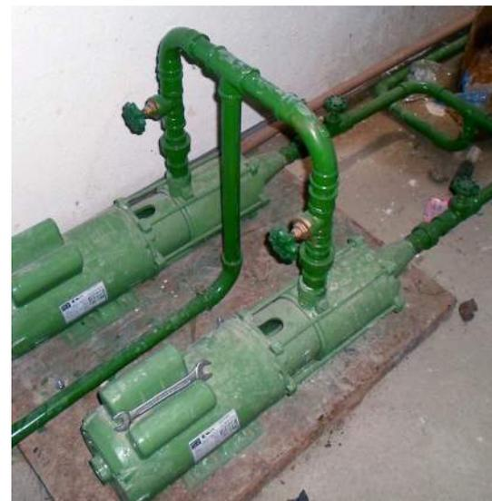
Foto - Bombas do sistema de elevação de água do reservatório inferior ao superior.
