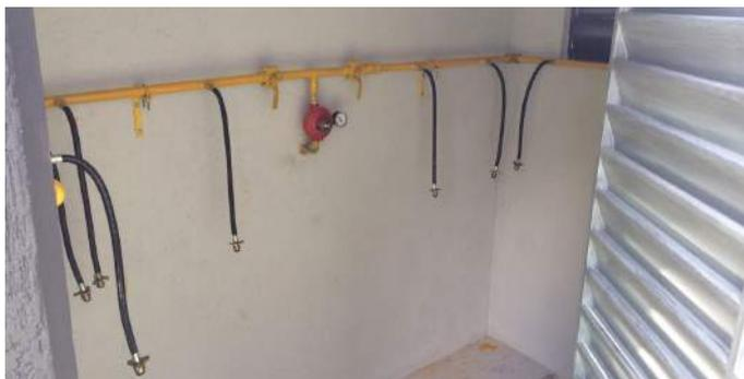
Imagem - Central de gás com a infraestrutura pronta para a instalação dos cilindros
