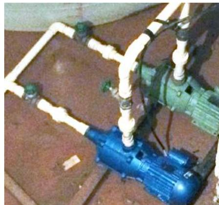
*Imagem - Bombas de recalque instaladas junto ao reservatório inferior*
